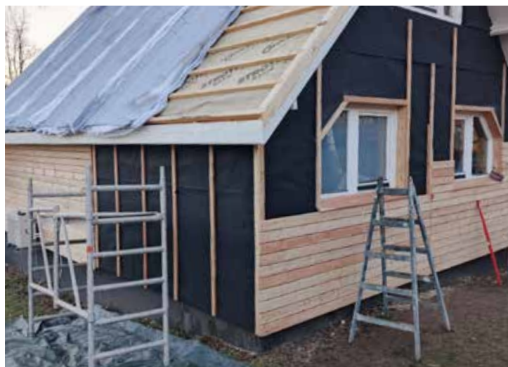
Dodatečné zateplení střechy proběhlo z exteriéru s opětovným využitím původní plechové krytiny
