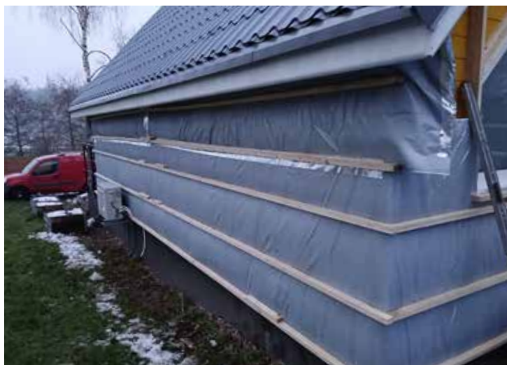
Montáž reflexní izolace SuperFOIL SF40BB na obvodové stěny
