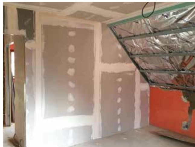
Parotěsná reflexní fólie SuperFOIL SF19+ pod krokvemi
