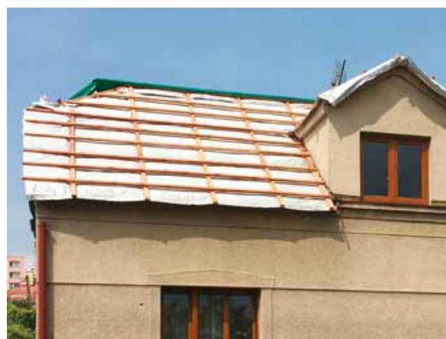
Paropropustná reflexní fólie SuperFOIL SF19BB nad krokvemi
